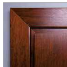
łączenie opasek pod kątem 45°
