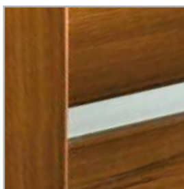
połączenie ramiaka, paneli i szyby
